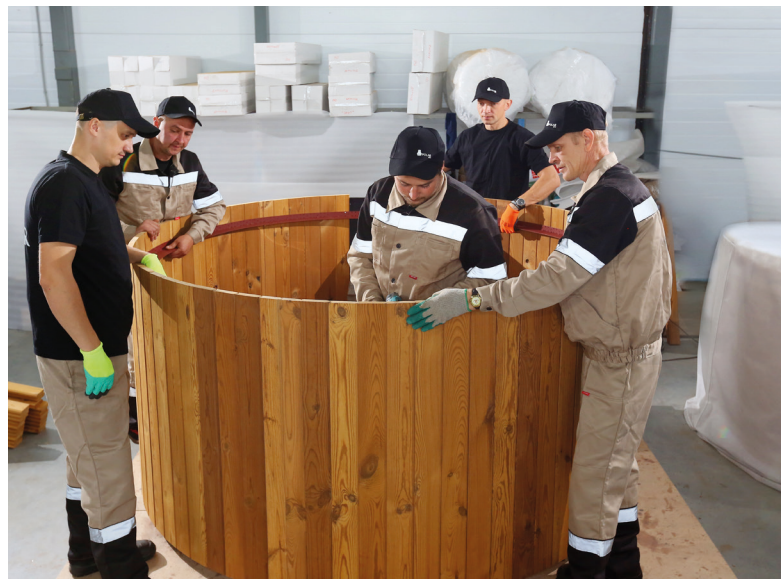
Установка декоративных деревянных ламелей.
