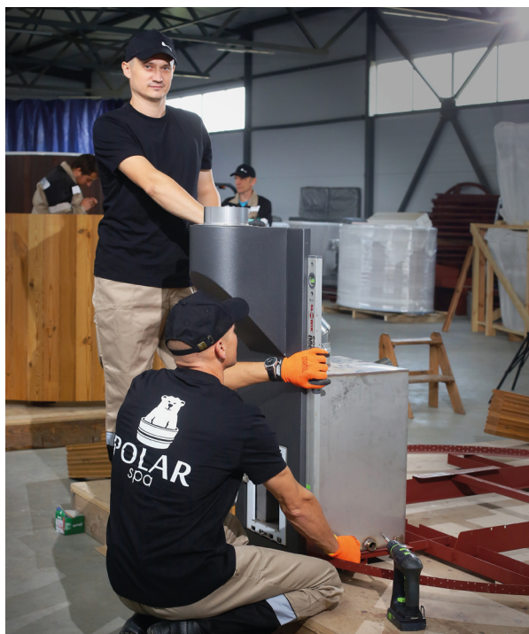
Установка печи на металлокаркас.
